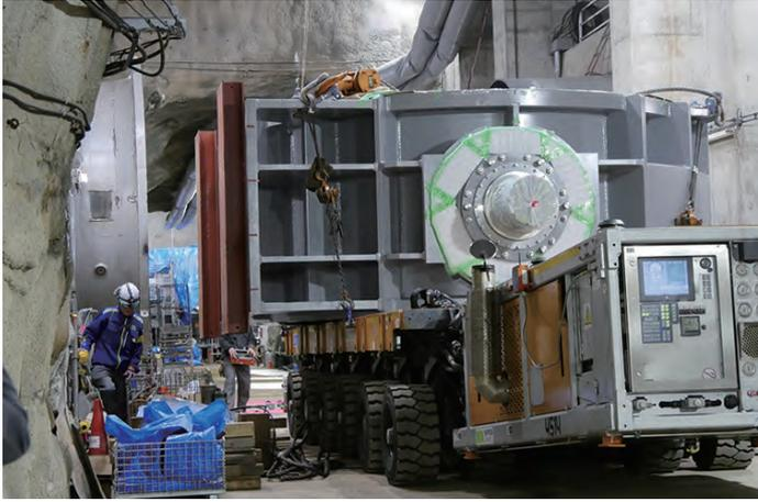
5月10日（金）に俣野川発電所の大規模改修工事の様子が報道陣へ公開されました。この日の工事は、導水路と水圧鉄管の間に設置するバルブの取替工事です。
