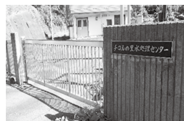
チロルの里水処理センター
