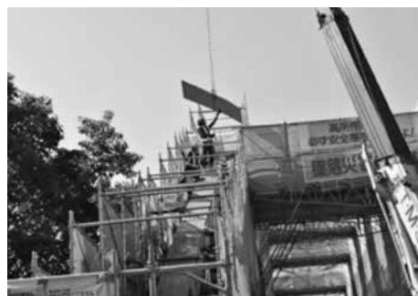
▲当て板をクレーンで持ち上げ運ぶ様子
