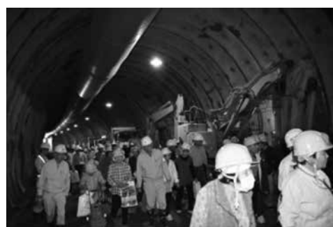
▲掘削のための重機が並ぶトンネル内の様子
