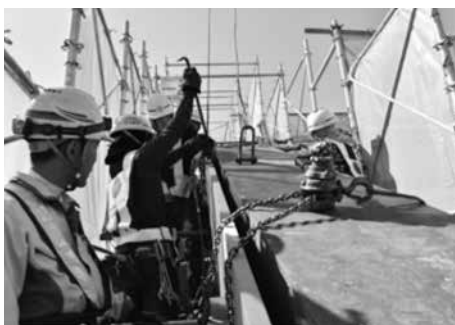
▲既設の部材に板を当て、ボルトで締めます
