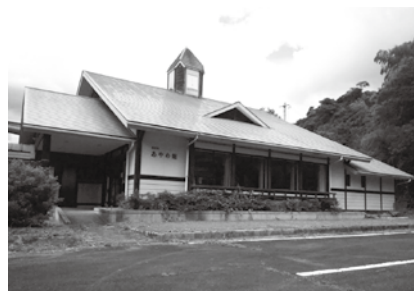
改修予定のあやめ館
