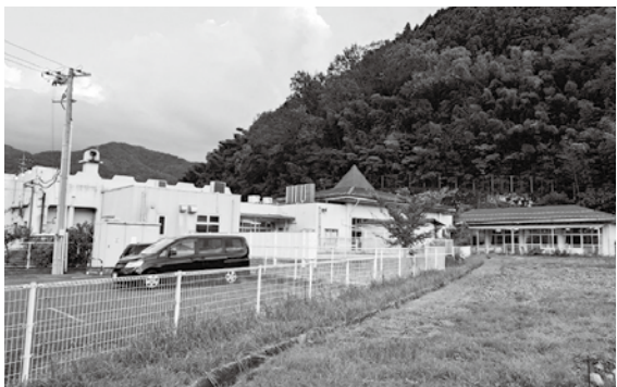
急傾斜地に隣接する子供の国保育園
