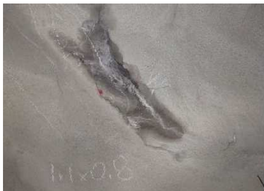
写真2.1 漏水を伴う吹付けコンクリートの劣化例
