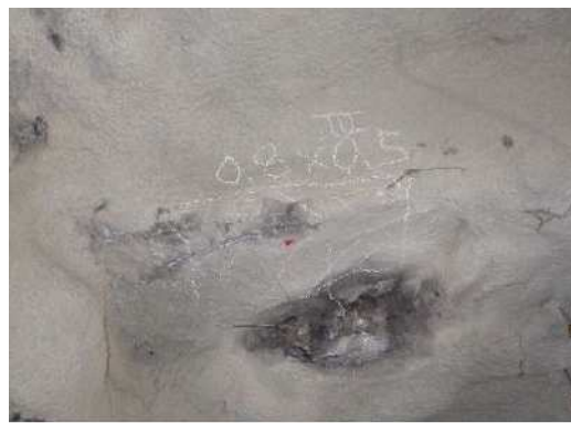
写真2.1 漏水を伴う吹付けコンクリートの劣化例
