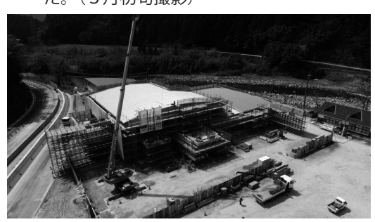
▲外部工事状況。右側は屋根工事中です。内部も建具取付、内装下地工事が急ピッチで進みだしました。(3月末撮影)
