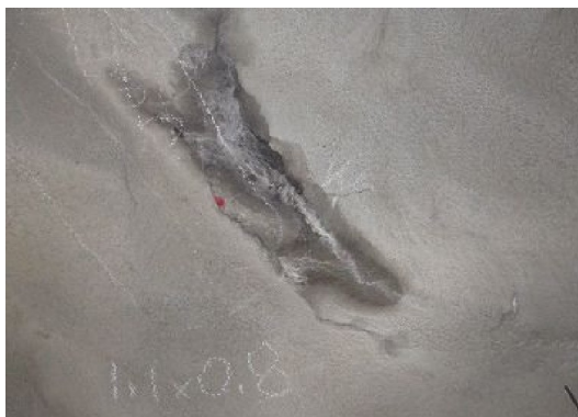
写真2.1 漏水を伴う吹付けコンクリートの劣化例
