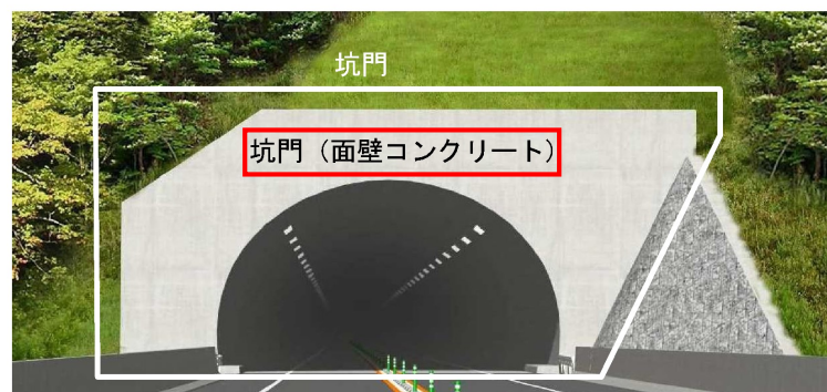
図3.1 トンネル本体工点検箇所
