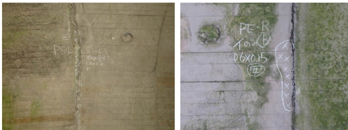
写真4.2 目地部のブロック化 左: PS、右: PE (いずれも II b 判定)
