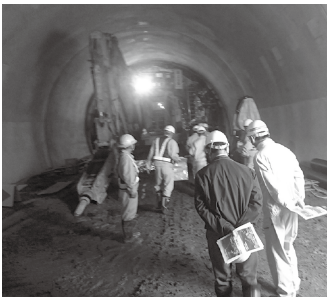
江府道路宮ノ谷トンネル
