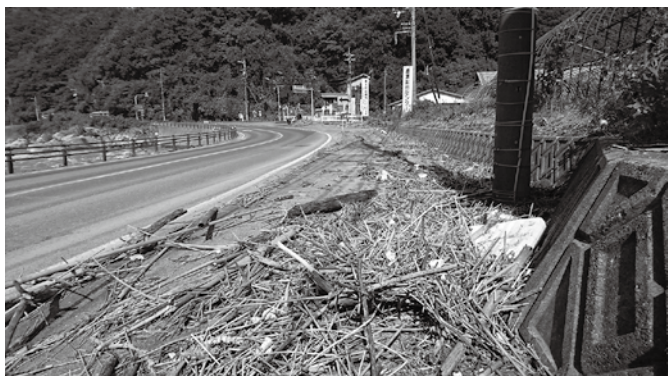
佐川地内国道冠水後の状況
