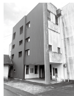
解体される日輪閣等
