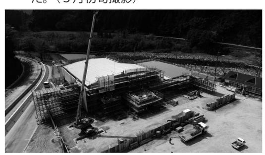
▲外部工事状況。右側は屋根工事中です。内部も建具取付、内装下地工事が急ピッチで進みだしました。(3月末撮影)
