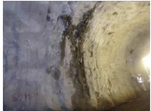
写真4.3 吹付け表面の漏水
