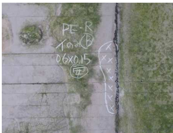
写真4.2 目地部のブロック化 左：PS、右：PE (いずれもⅡb判定)
