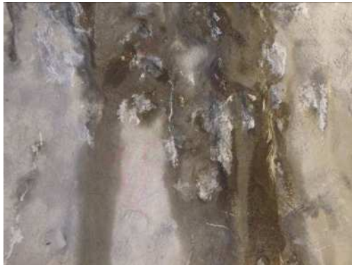
写真4.3 吹付け表面の漏水
