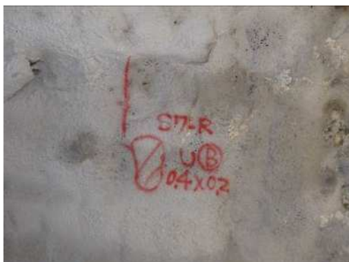
写真4.4 吹付け表面のうき、はく落箇所
