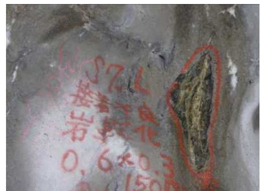
写真4.4 吹付け表面のうき、はく落箇所
