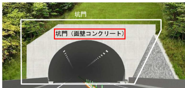
図3.1 トンネル本体工点検箇所
