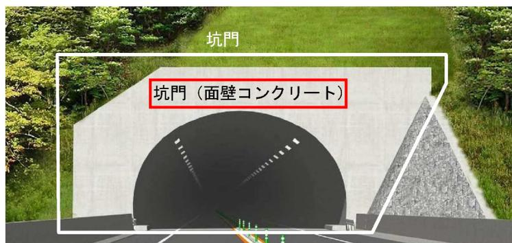
図3.1 トンネル本体工点検箇所
