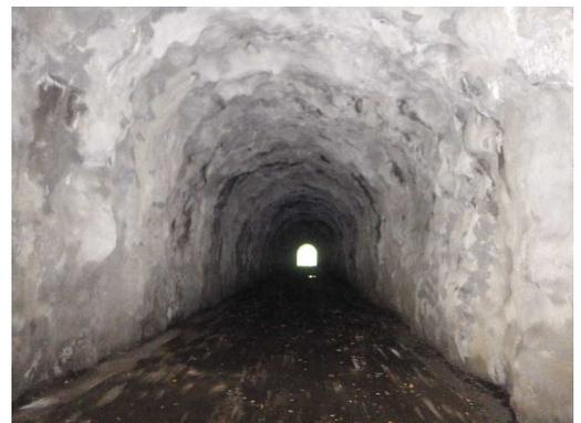
厚さ 10cm 程度、コンクリートを吹付けて内面を補強
