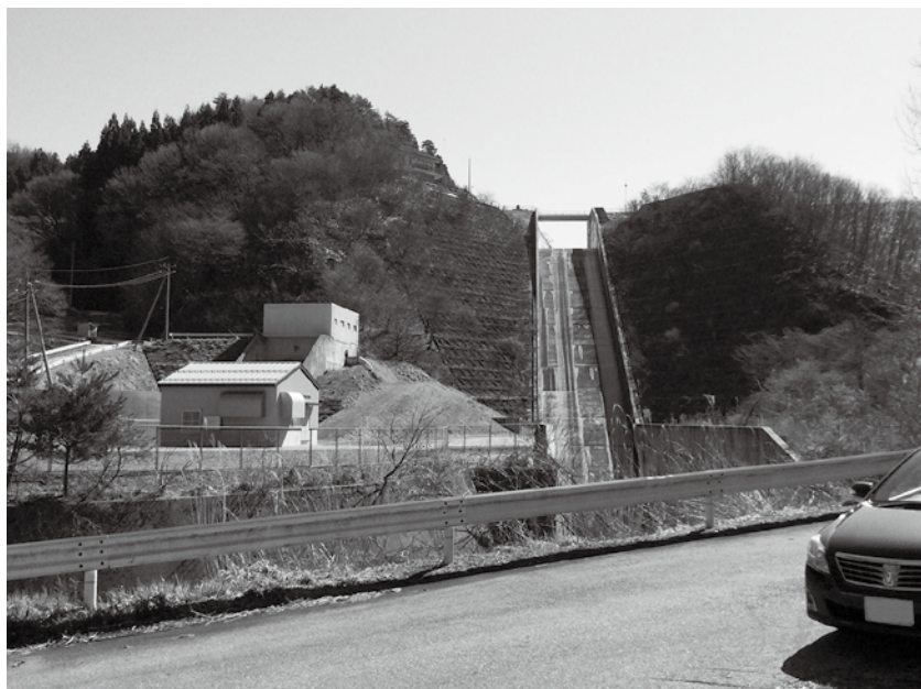
下蚊屋発電所
