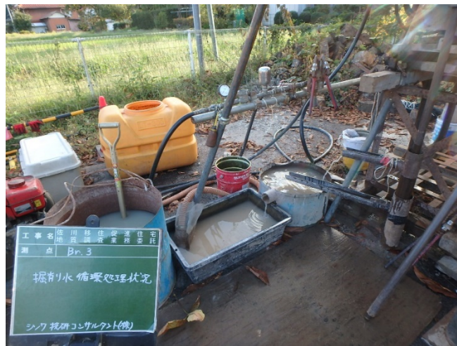
図 2.2.8 掘削水循環処理の様子
