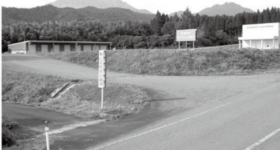
災害用備蓄一部保管場所
