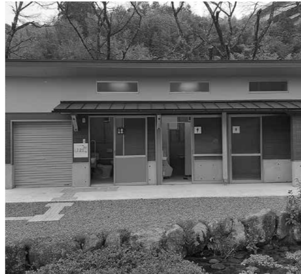
せせらぎ公園グラウンドゴルフ場トイレ新築
