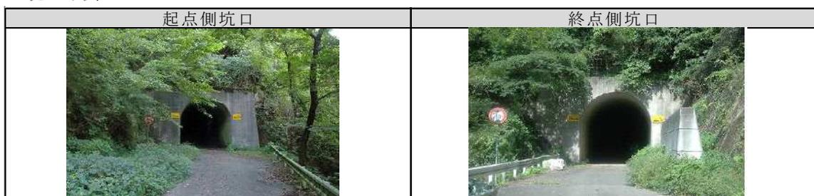
湖岸トンネルは両坑口に約20mずつ覆工コンクリート区間を有しますが、延長138.1mのうち70%にあたる約100mが素掘りにコンクリートを吹付けた構造（以降、吹付け区間）となっています。
