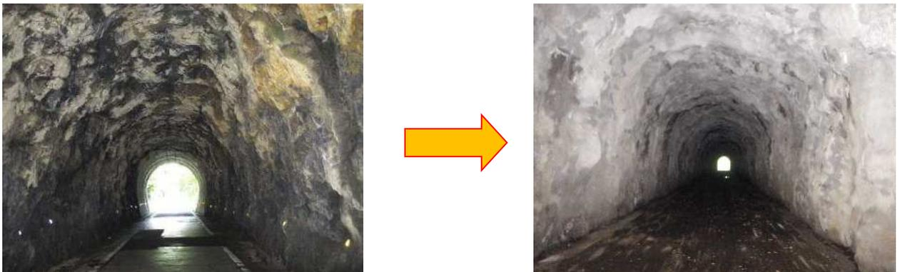
厚さ 10cm 程度、コンクリートを吹付けて内面を補強
