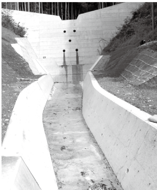
下安井吹山谷川砂防堰堤
