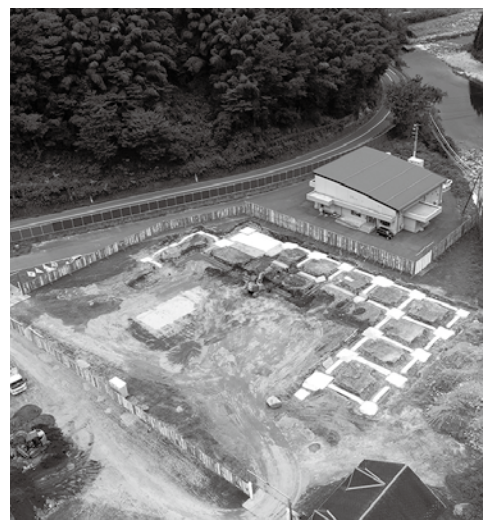
建設工事が始まった新庁舎
