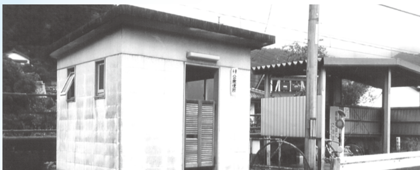
武庫駅トイレ
