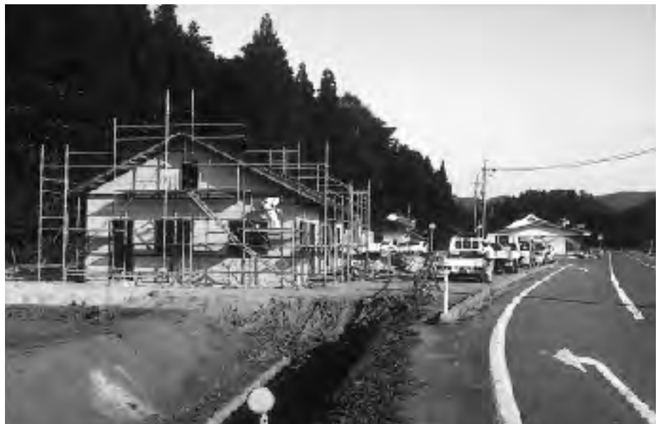
建設中の吉原地区農業集落排水終末処理場
