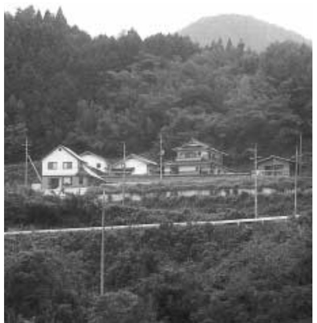
久連分譲住宅
