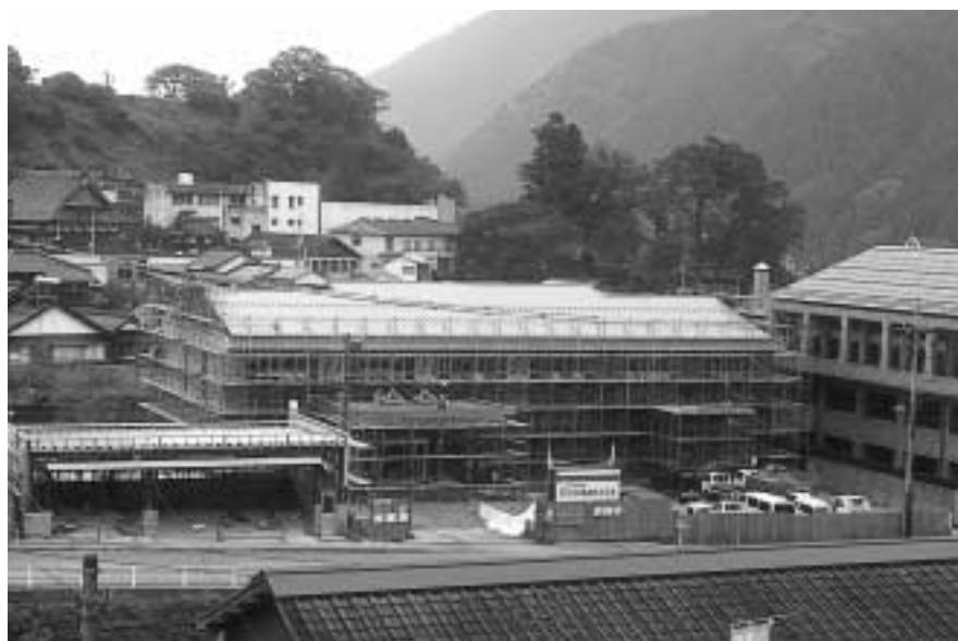
進む防災情報センター建設工事（江尾）
