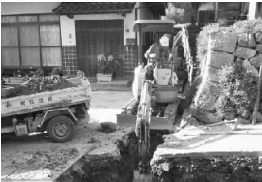
公共下水道工事 (柿原地内)
