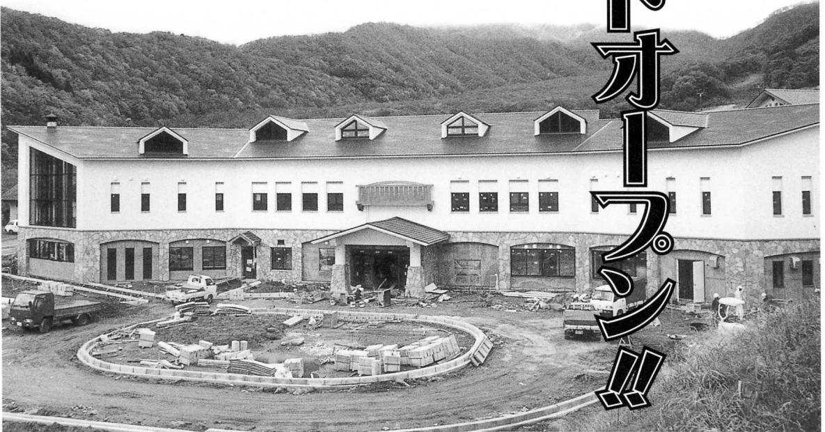
●建設が順調にすすむエバーランド奥大山
