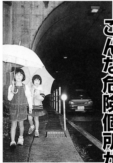
●照明の暗い苦裕トンネル (助沢)
