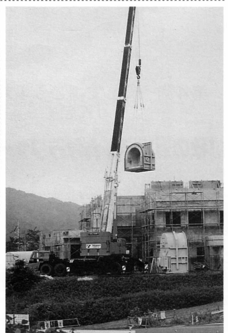
建設中の共同焼却場 (日野町黒坂地内)
