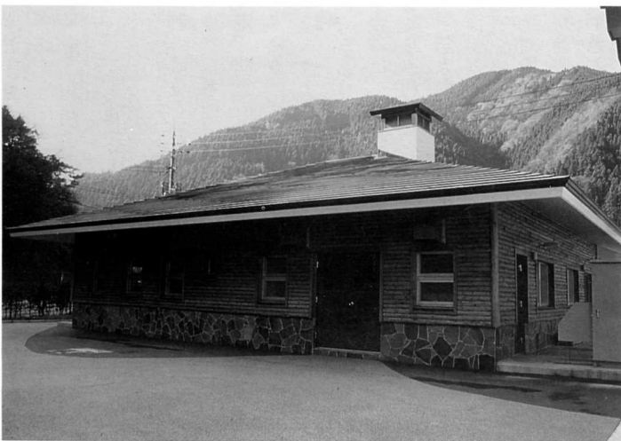
▲本年度から供用開始となる集落排水終末処理場（クリーンセンター川筋）
