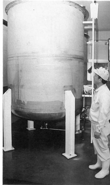
タンクローリーで運ばれた原水はまず、調合タンクに貯蔵されます ①
