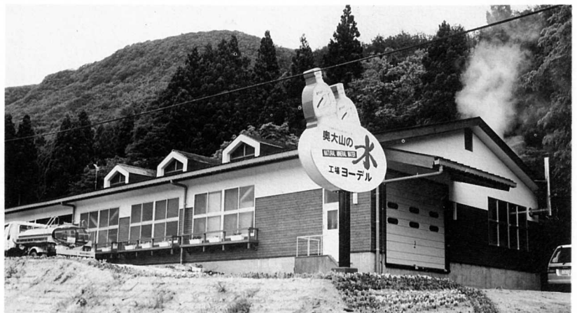
▲水工場の全景
