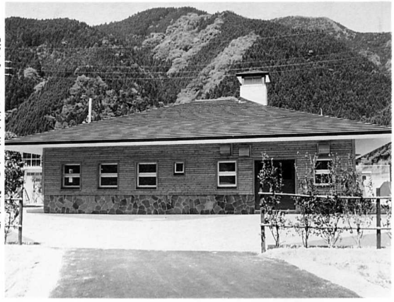
▶完成した集落排水の処理場
