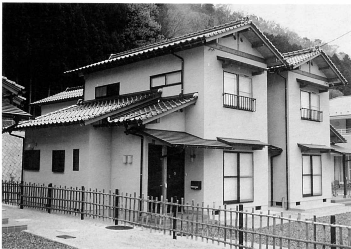
▲完成した町営住宅
