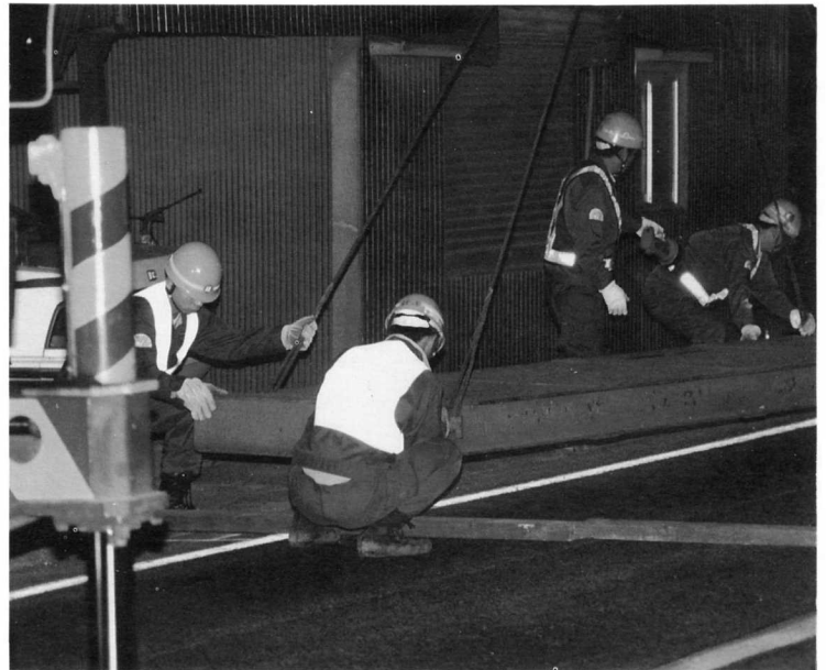
▲手際よく、橋の補強工事が行われる(深夜2時)
