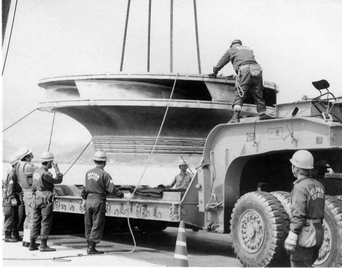
▲慎重にトレーラーの荷台に積載されるランナ(ポンプ水車)
