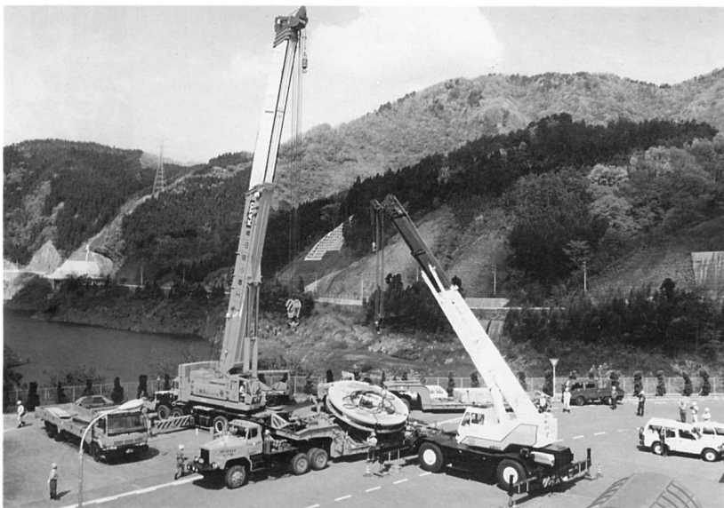
▲ランナを2台のクレーン車がつり上げ、いよいよ作業開始
