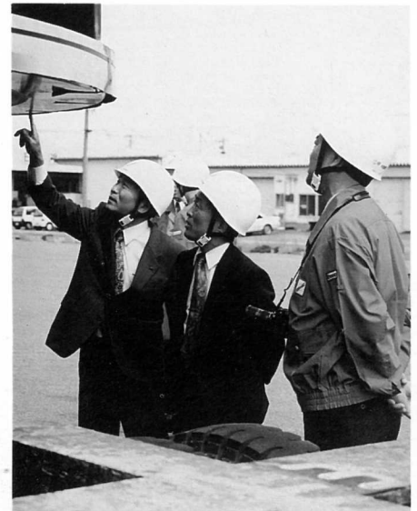
▲ランナの点検をする俣野川発電所建設の関係者(米子港)
