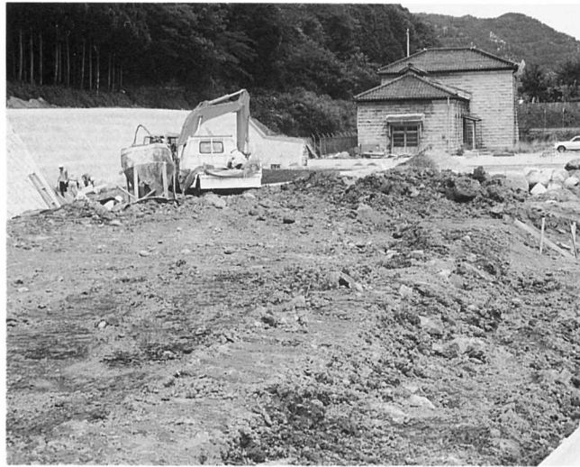
▲整地の進む町営住宅敷地
