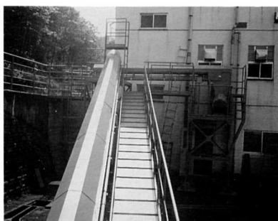
▲更新なった汚泥搬送ベルトコンベアー
