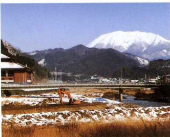
▲すでに工事が始まった夜振橋周辺
