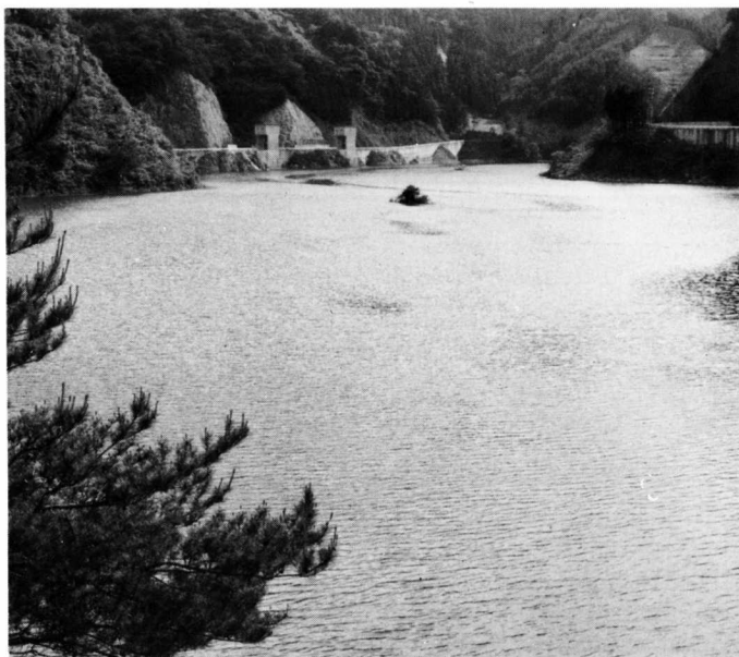
▲俣野川ダム湖周辺等を整備
