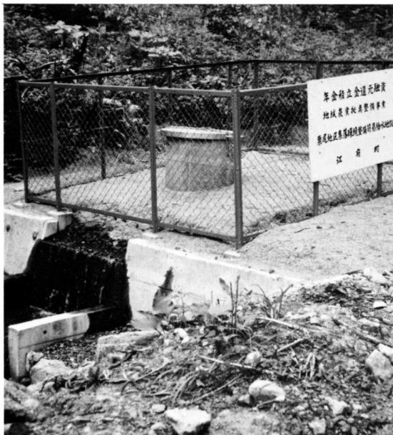
◀ 新設された栗尾地区簡易水道
