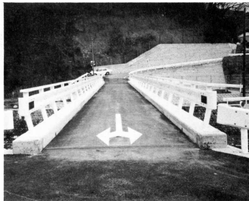
▲完成した上小江尾橋
