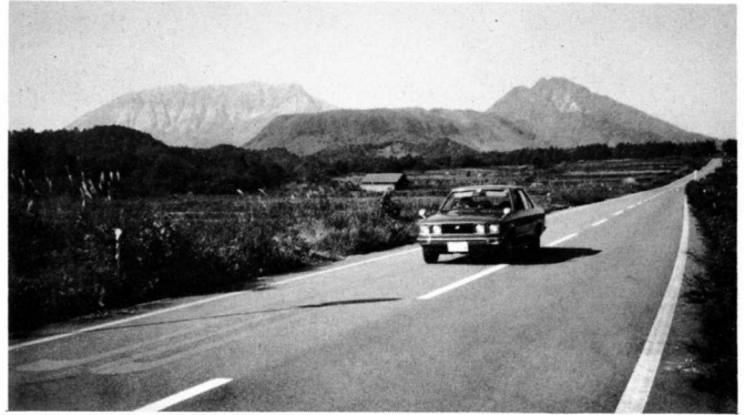
▲下蚊屋地区と笠良原地区を結ぶ広域農道
