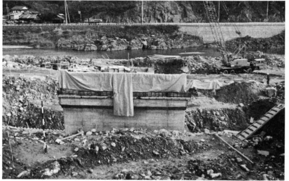
▲現在、白住大橋工事は、橋台の工事が進められています
